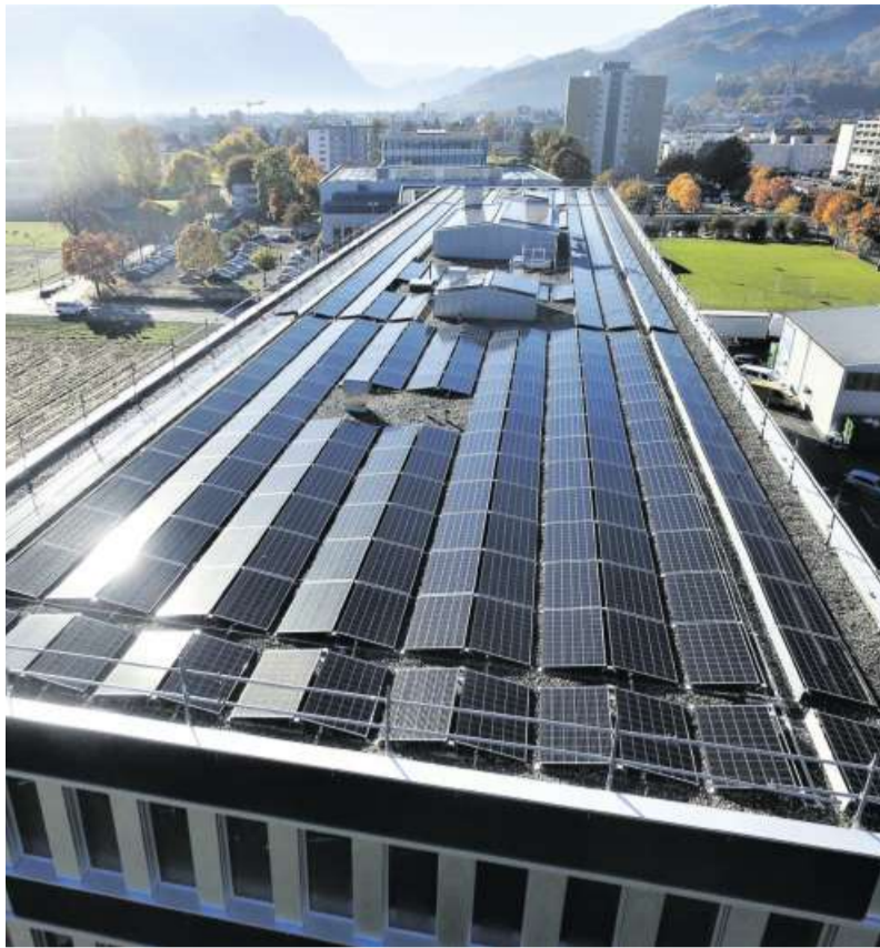
Das Gebäude ist ein nachhaltiges Kraftwerk. Die gesamte Gebäudetechnik für Lüften, Heizen und Kühlen wird komplett mit erneuerbaren Energien betrieben..
